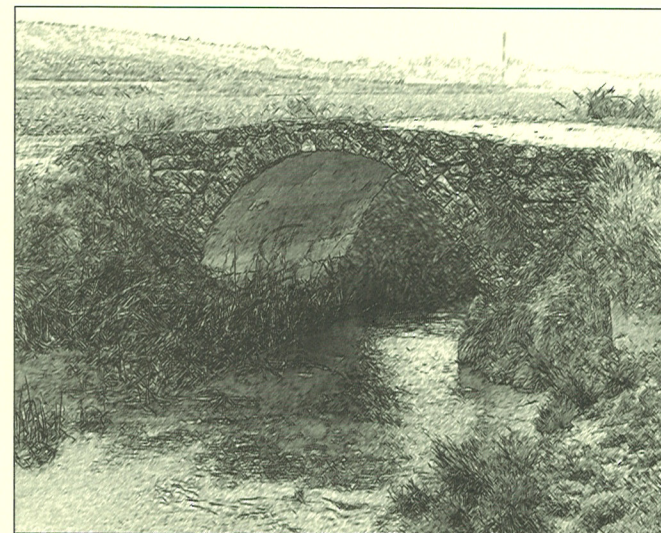
Puente de San Pedro
